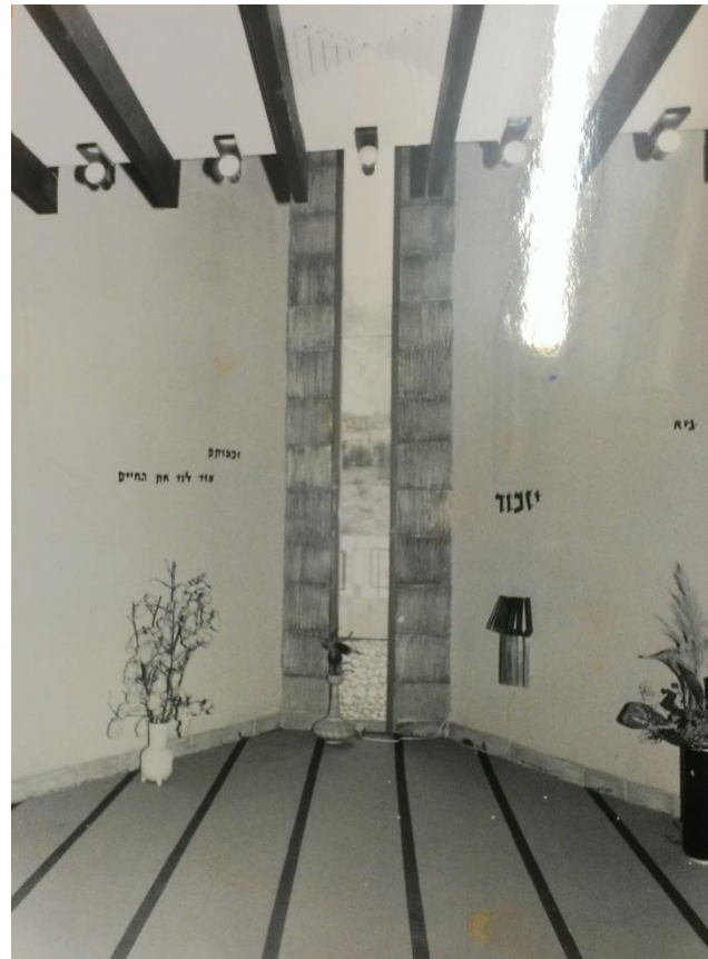
10. חדר הזיכרון - החלון בין שני הקירות החיצוניים (צילום ללא שם ותאריך, ארכיון הקיבוץ)
